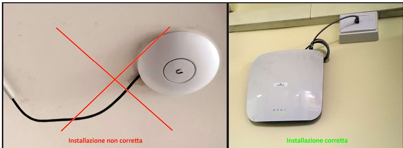
Figura 10 – Installazione corretta dell'Access Point
